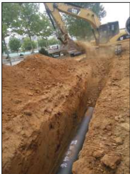
挖掘机开挖管沟
